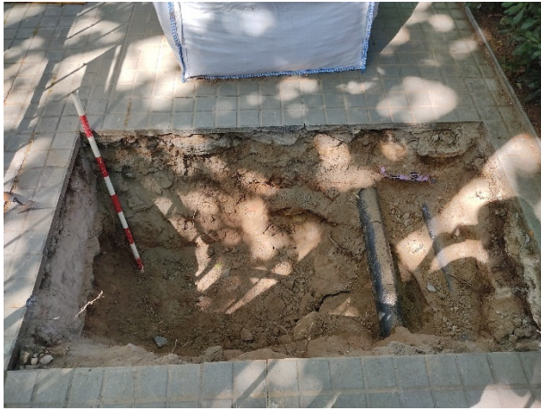
19. Inici dels treballs, on s'observa el tub UE 109.
