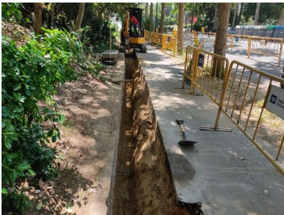
Part central de la rasa de l'avinguda de Miramar.
