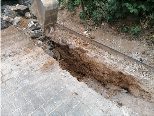
33. Procés d'excavació del tram nord de la rasa.
