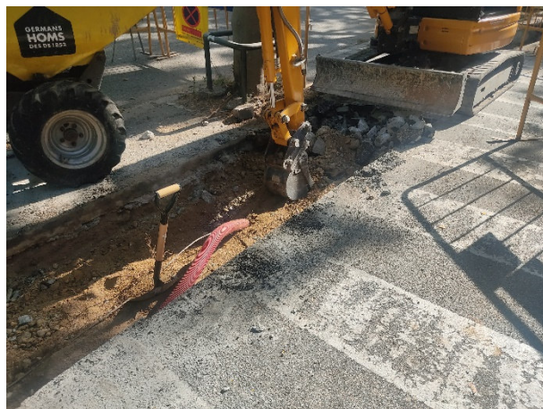
17. Procés d'excavació de l'entrada al Viver dels Tres Pins.
