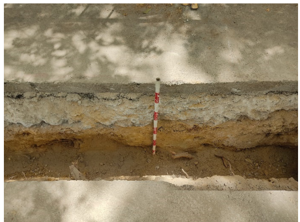
12. Perfil sud, de la part central de la rasa, on s'observen les UE 01, 02 i 06.
