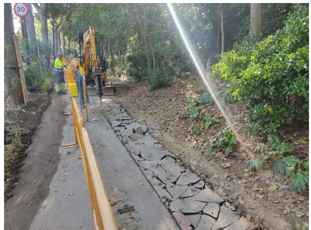
4. Procés d'excavació del paviment actual, UE 01.
