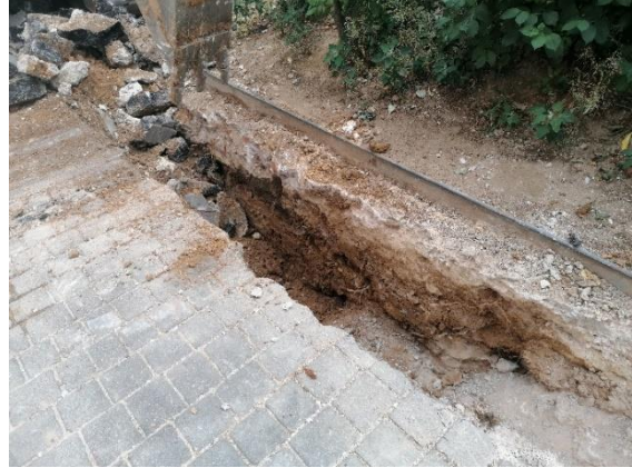
Part nord de la rasa del passeig de Miramar
