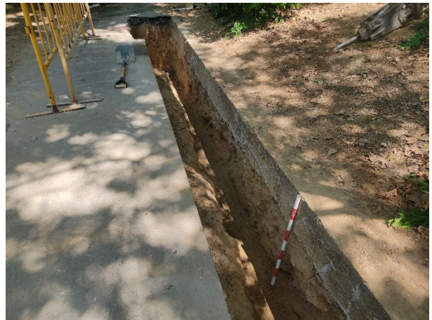
2. Tram oest de la rasa, on s'observa en el marge sud el paviment (UE 01), situat sobre l'UE 04.
