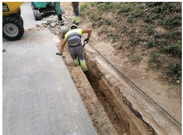
36. Procés d'excavació del tram nord.
