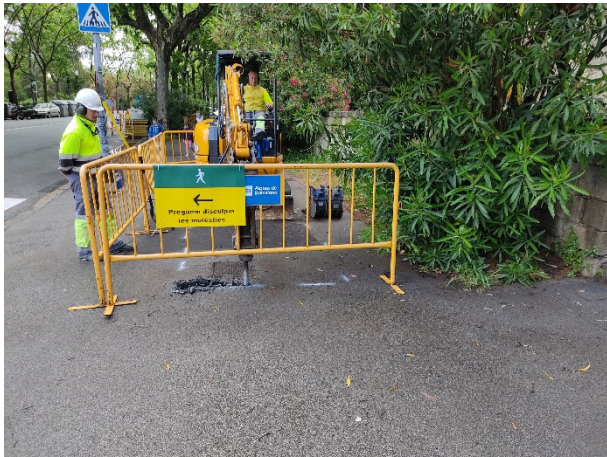
1. Fotografia inicial dels treballs d'excavació de la rasa.
